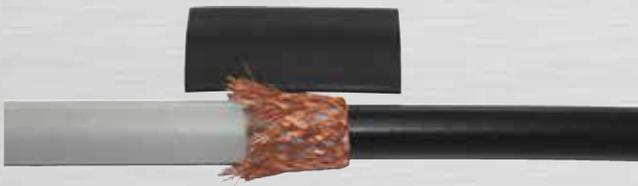
Bild 67: Positionierung des Schrumpfschlauches
